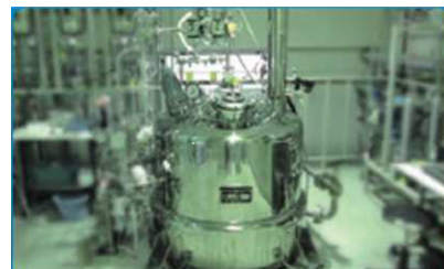
バイオマスプラスチック製造設備
