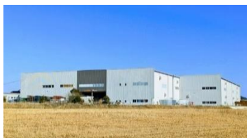
新工場の建設費
