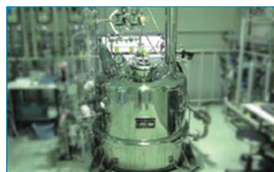
バイオマスプラスチック製造設備
